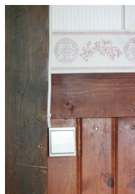
Yläosan hennosti raidoitettu Haltex-levy on vuodelta 1957, boordi on myöhempi lisäys. Puolipanelointi on punaruskea. Sähkövedot 1980-luvulta.
