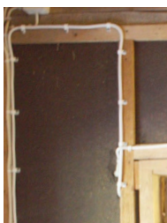
Seinien sisäpinta on pinnoitettua vanerilevyä.
