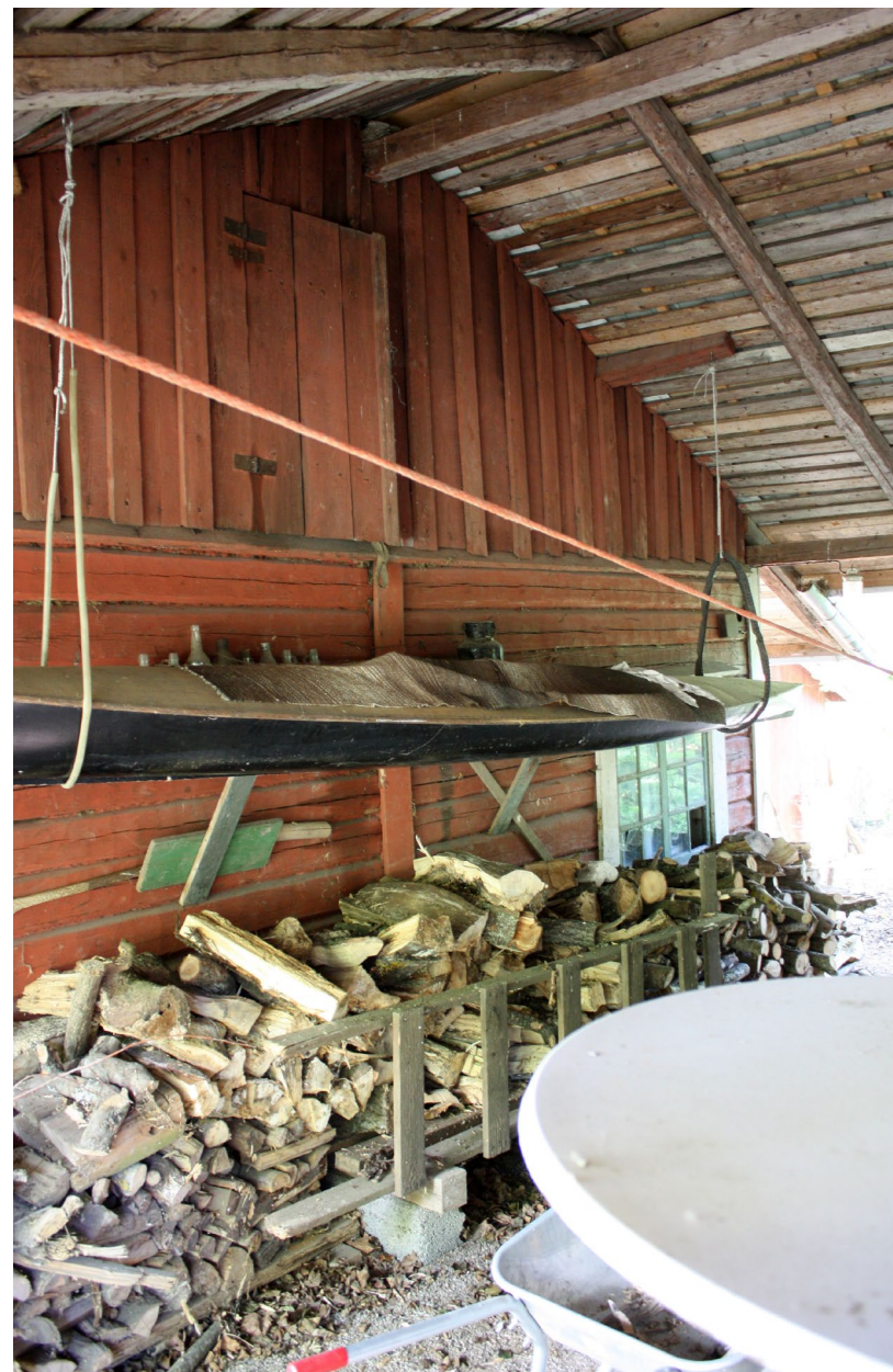
Savusaunan itäjulkisivu. Savusaunan ja venekatoksen liitoskohta.
