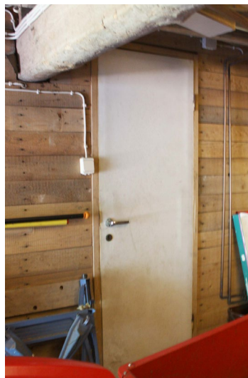
Varastosta keittiöön kulkeva ovi. Kuvassa näkyvä palkki jatkuu keittiön olohuoneen puoleiseen seinään asti.
