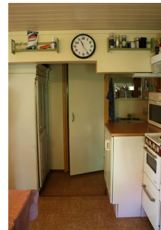
Keittiöstä. Edessä näkyvä ovi vie lastenhuoneeseen ja oikealla ovi vie varastoon. Varastosta keittiöön tuleva palkki on kavennettu ja koteloitu.
