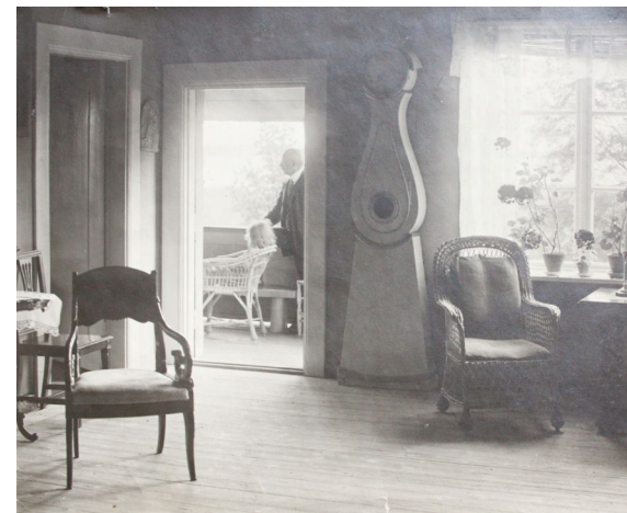
Sisäkuva salista noin vuonna 1910-1912. Ruokasaliin puhkaistu uusi kulku entisestä lasten kamarista näkyy kuvassa vasemmalla. Seinät ovat päällystetyt. / Suvirannan yksityisarkisto.
