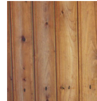
Rakennusaikainen alakatto on vernissalla käsiteltyä paneelia.
