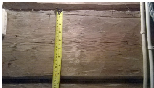
Vuoraamatonta piiluttua hirsiseinää on näkyvissä kellarin sisäänkäynnin kohdalla. Luultavasti ulkoseinät ovat olleet maalamatonta hirttä ennen seinien vuoraamista laudoituksella.
