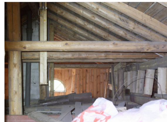
Kirjaston ja makuuhuoneen yläpuolinen ullakko. Päädyssä näkyy rakennuksen lautarakenteinen eteläpäätyyn yläosa. Oikealla alla 1980 asennettu metallinen vahvistuspalkki ja tuet tämän ja vanhan puisen palkin välissä.
