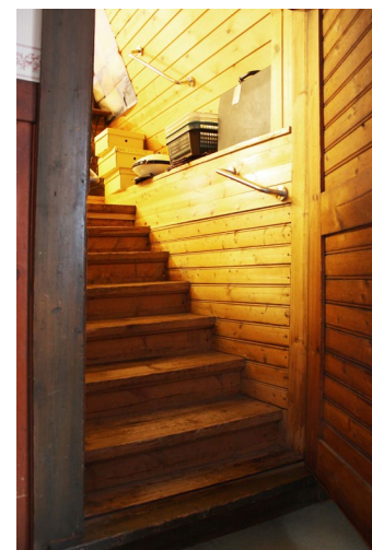
Ullakolle vievät portaat yläkerran tampuurista. Oikealla olevat kaiteet ovat viimeisimpiä lisäyksiä. Aikoinaan portaan linjassa kulkenee kattorakenteen tukipilarit katkaistiin.
