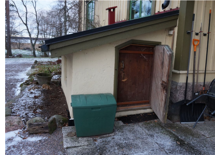
Kellarin sisäänkäynti sijaitsee asuinrakennuksen kaakkoisnurkalla.
