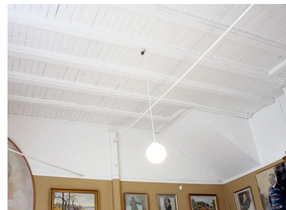
Ateljeen katon rakenteita. Vasemmalla näkyy 1935-1936 asennettu puupilari tukemaan kattoa. 1950-luvulla asennettu vetotanko on kiinnitetty pitkällä julkisivuilla oleviin följareihin. Aivan oikeassa reunassa näkyy vekseliin kiinnitetty pultti.
