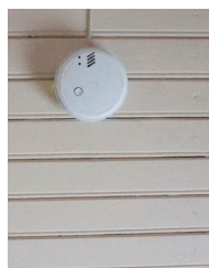
Alakattopinnan panelointi on alkuperäinen.
